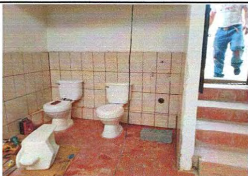
Foto 3: Instalación de sanitarios
