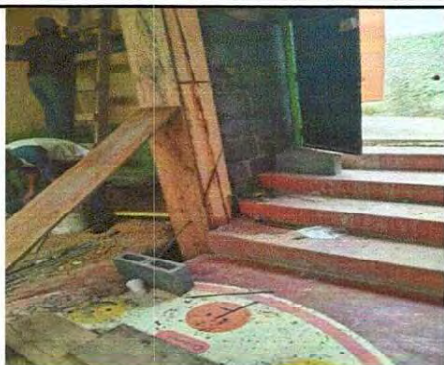
Foto1: Rehabilitación de pared que resguarda las baterías
