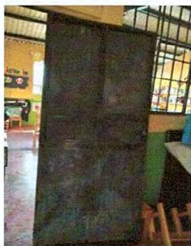
Foto 3: Mantenimiento de puerta de metal (lijado, rectificación aplicación de anticorrosivo y esmalte)
