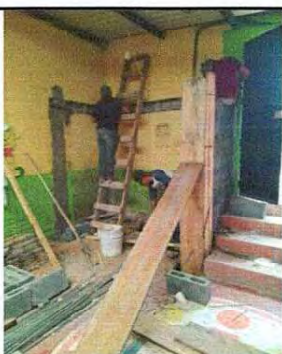
Foto 5: Rehabilitación de pared que reguarda las baterías
