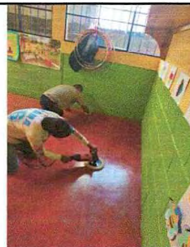
Foto 4: Mantenimiento de piso lustrado y pilido
