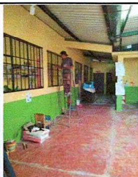
Foto 5: Ventanas mantenimiento de estructura de metal
