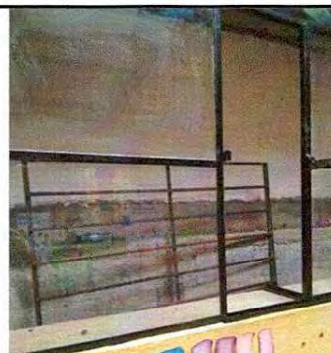
Foto 6: Sustitución de ventana
